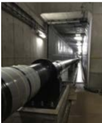
尼崎・久御山ライン（工事状況）
