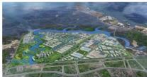
ベトナム フォーミー3 工業団地 都市ガス供給
