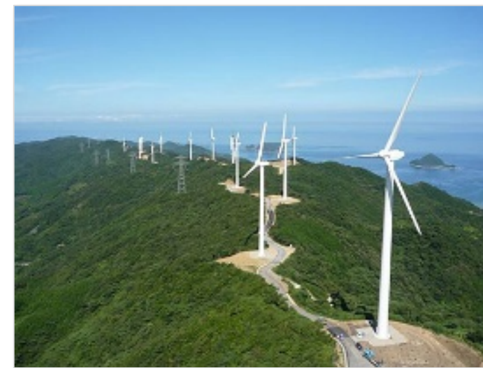
広川明神山風力発電所
