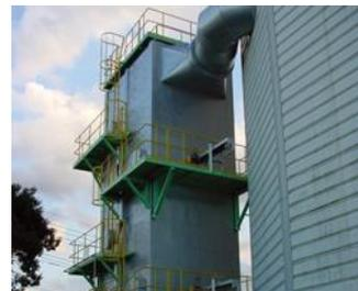
触媒式ダイオキシン類分解除去装置
