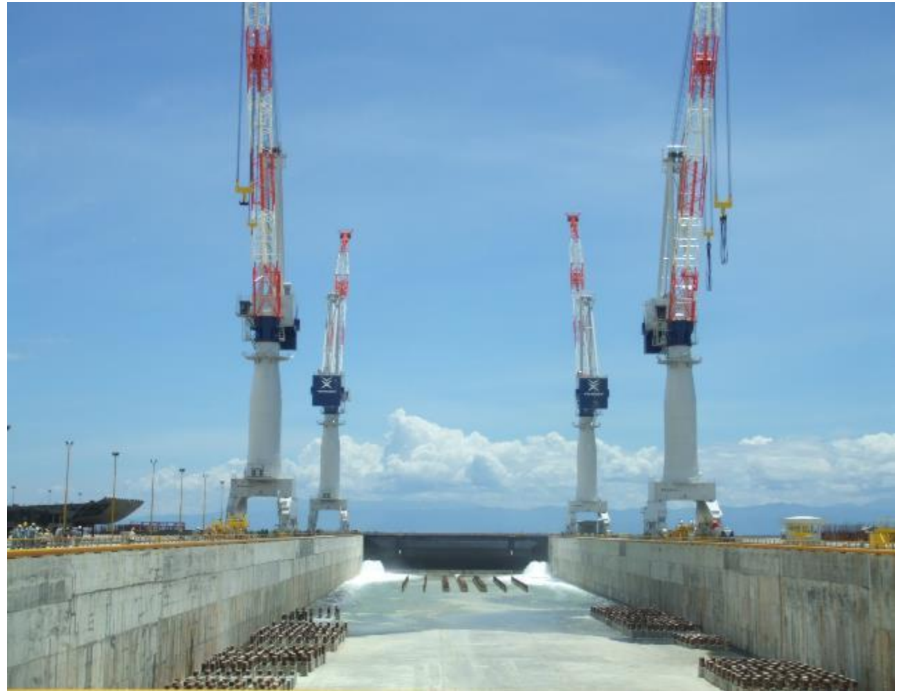
2009年 第1建造ドック（注水）
